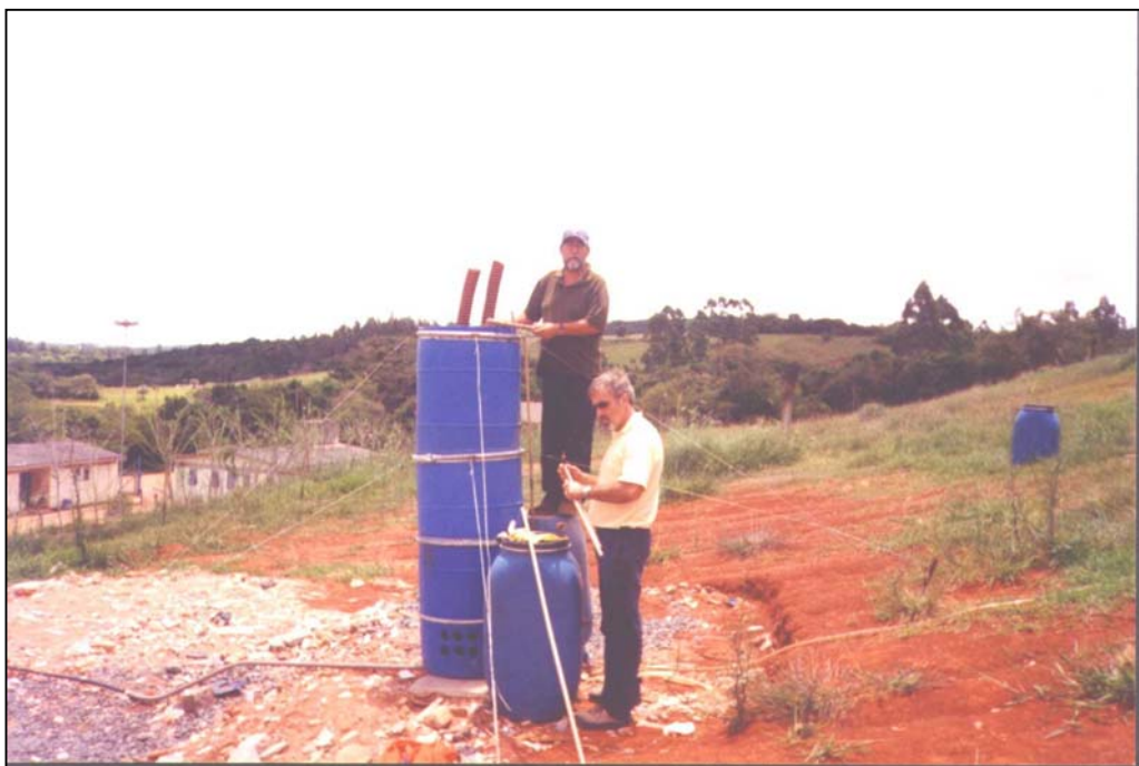
Figura F.28 – Registro fotográfico da montagem do filtro aeróbio utilizado no experimento (Fase B)
