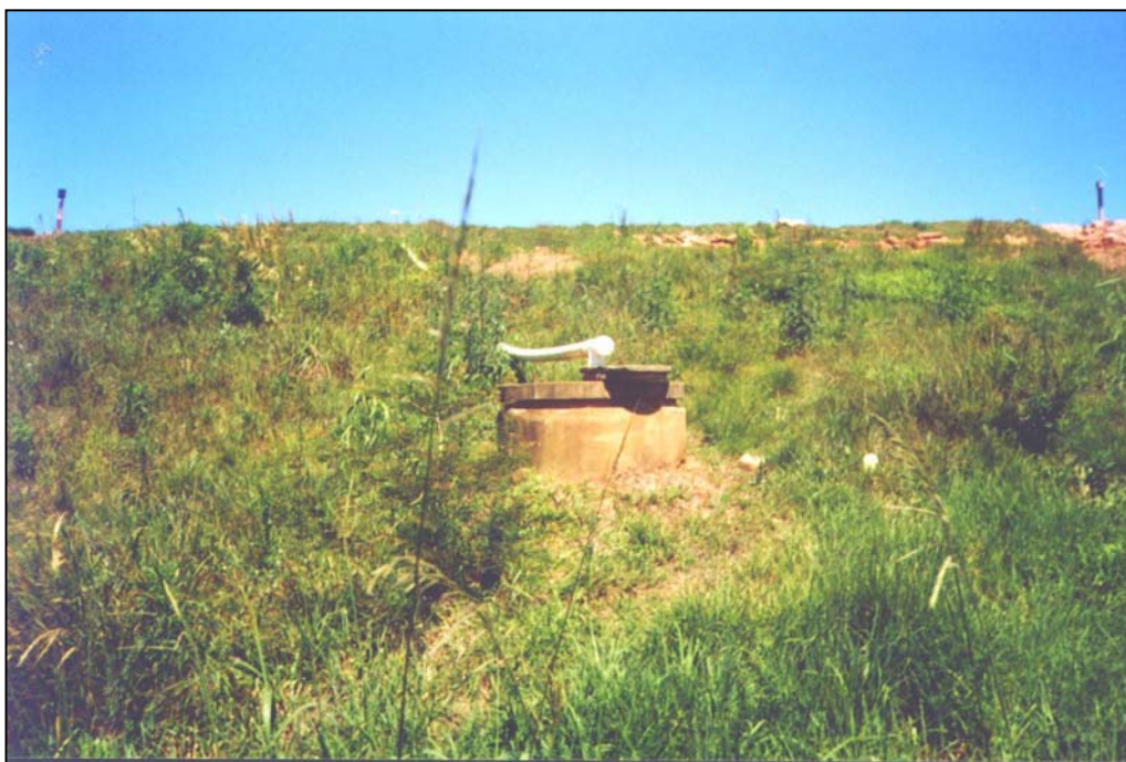
Figura F.19 – Poço de captação do lixiviado bruto utilizado na Fase A da pesquisa, sito no Aterro Sanitário Santa Tecla, Gravataí
